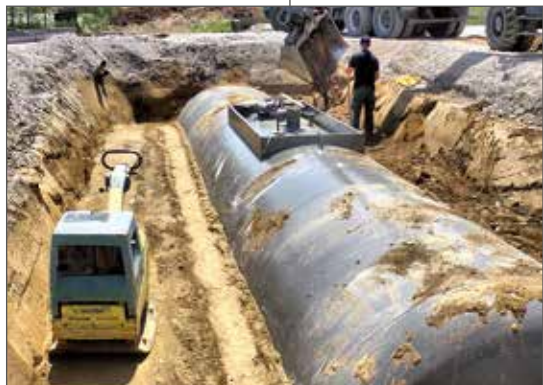
Установка подземного резервуара системы автономного газоснабжения LPG/SNG
